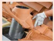
Positionner l'ensemble en s'assurant de la bonne étanchéité avec la membrane (si nécessaire, suivant la configuration de pose et du modèle de tuile, prévoir une découpe de la mousse).
