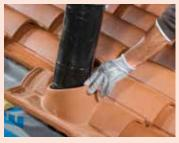
2 - Positionner correctement le manchon au centre de la tuile à douille. Le sens d'inclinaison du manchon est indiqué par
