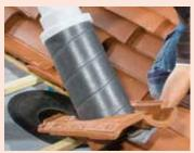
6 - Mettre le manchon dans la tuile à douille, puis l'isolant et visser le raccord multi-diamètres. Fixer le collier de serrage autour du raccord. Si gaine raccordée sur 160mm, découper le raccord diamètre 125mm jusqu'au pas de vis.
