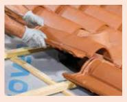
1 - Déterminer le positionnement final de la tuile à douille. Enlever les tuiles du rang supérieur ainsi que la tuile voisine recouvrant la tuile à douille.
