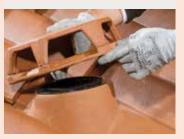
8 - Positionner la grille anti intrusion et fixer la lanterne avec un mastic de collage sur la tuile à douille.
